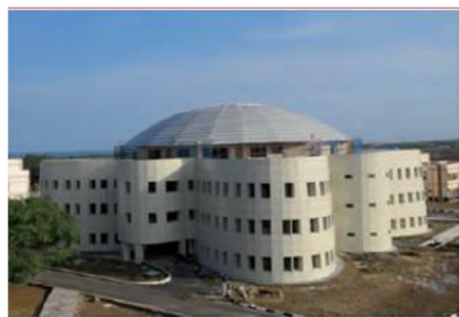
12 運転訓練センター
