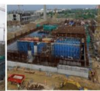
6 再処理プラント
